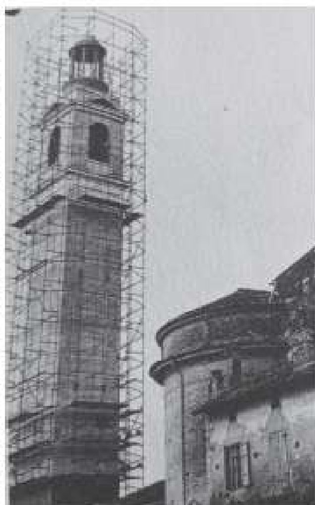
4 - La Torre campanaria in costruzione
