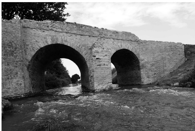
Il Ponte dei "due Ponti", lato est
