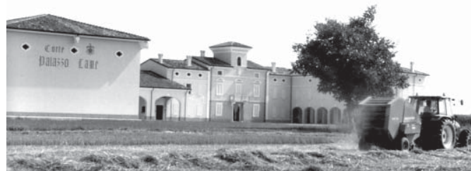
Cascina Lama dopo la ristrutturazione
