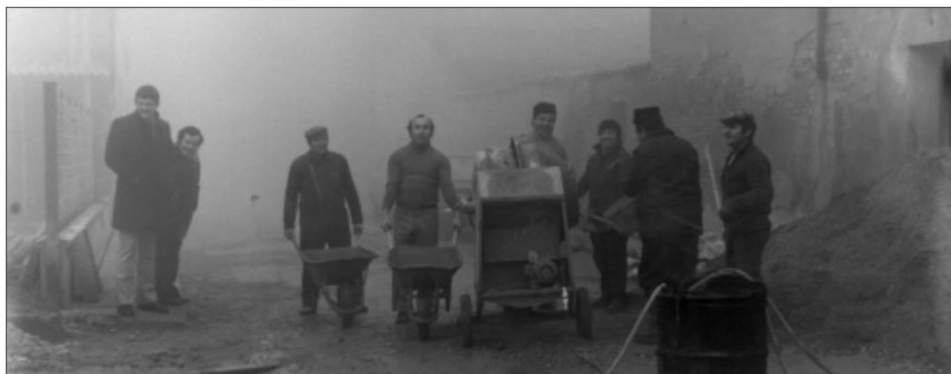
Lavori per la costruzione della sede. Da sinistra: Pierangelo Fertonani, Giacomo Guaiatelli, Ernestino Pezzali, Silvio Ferrari, Giovanni Bresciani, Quinto Pezzali, Bruno Antonietti. Di spalla Adelmo Buttarelli.
