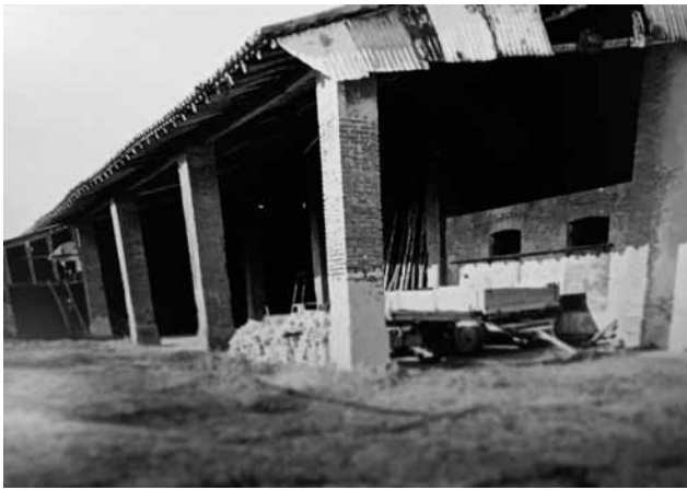
Il porticato della cascina Maestà
