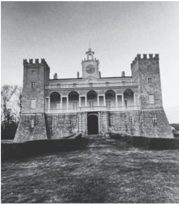
Villa Medici del Vascello, San Giovanni in Croce (Cr), fronte meridionale. Le torri d'angolo con base a scarpa sono quattrocentesche, posteriore (tardo Seicento?) la loggia a serliane.
